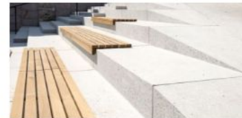
2 CAST-IN-PLACE CONCRETE SEATWALL SCALE: N.T.S.
