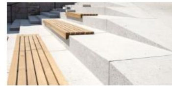
2 CAST-IN-PLACE CONCRETE SEATWALL SCALE: N.T.S.
